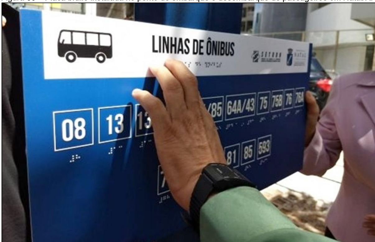
Figura 66 – Placa braile instalada no ponto de embarque e desembarque de passageiros em Natal/RN
