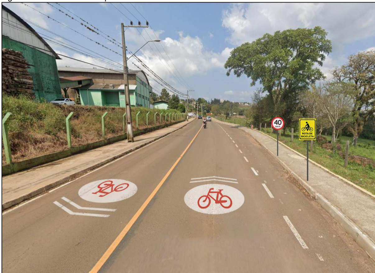
Figura 114 – Estrada Municipal Pedra Lisa com ciclorrota
