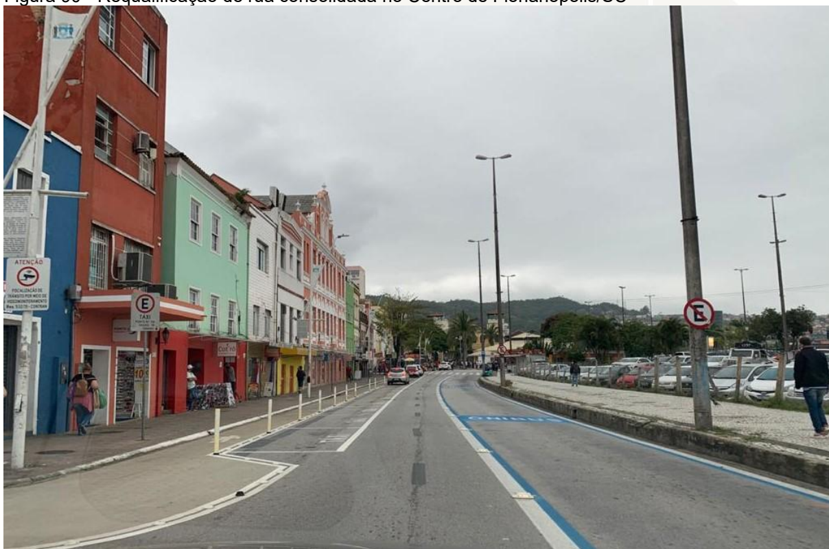
Figura 90 - Requalificação de rua consolidada no Centro de Florianópolis/SC
