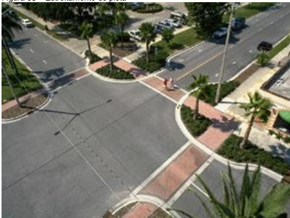
Figura 98 – Estreitamento de pista
